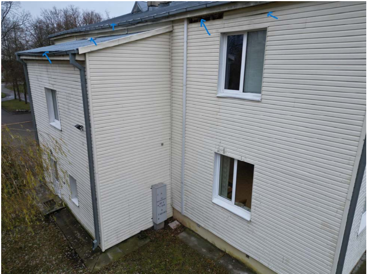
06 pav. Defektų rytiniame fasade fotofiksacija
