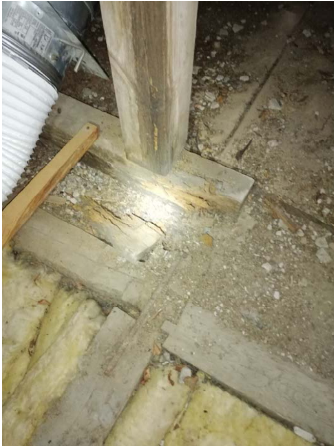
19 pav. Stogo konstrukcijos (virš patalpos inv. Nr. 2-15) pažeistos biologinių kenkėjų
