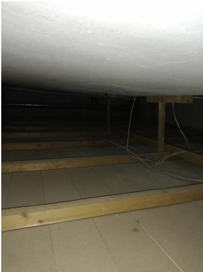
28 pav. Rekonstravimo metu pertvaros ir sienos apdailintos g/k plokštėmis ant medinio karkaso. Žemiau IIa. perdangos (30-40cm) įrengtos pakabinamos g/k plokščių ant medinio karkaso pakabinamos lubos.
