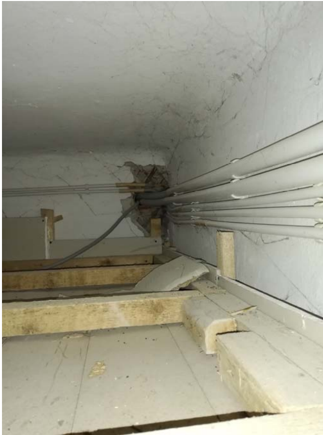
29 pav. Rekonstravimo metu pertvaros ir sienos apdailintos g/k plokštėmis ant medinio karkaso. Žemiau IIa. perdangos (30-40cm) įrengtos pakabinamos g/k plokščių ant medinio karkaso pakabinamos lubos.
