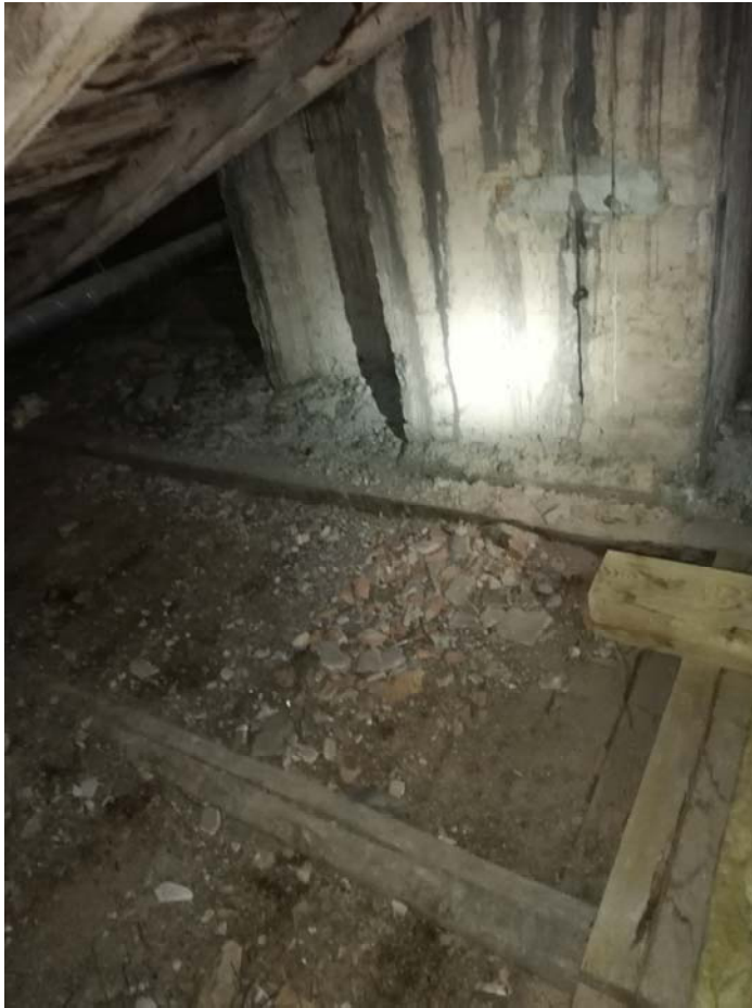
25 pav. Ila. perdangos sijos, įrengtos greta kamino virš patalpos inv. Nr. 2-23
