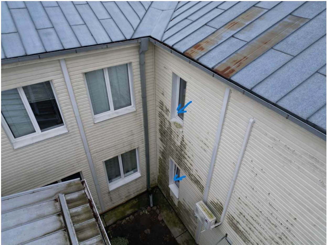
07 pav. Fasado ir stogo projektuojamo keltuvo zonoje fotofiksacija
