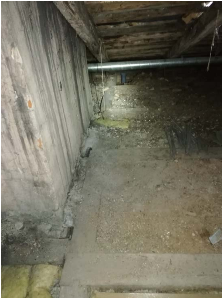
26 pav. Ila. perdangos sijos, įrengtos greta kamino virš patalpos inv. Nr. 2-24
